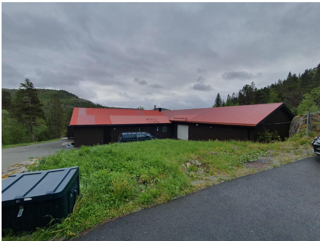
Figur 11: Vannbehandlingsanlegget i Ørland kommunale vannverk
