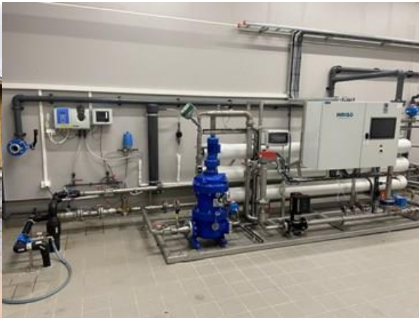
Figur 23: Prosess i vannbehandling ved Elveng vannverk
