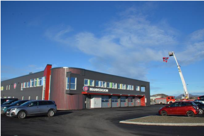
17. februar ble åpningen av den nye brannstasjonen på Brekstad markert.
